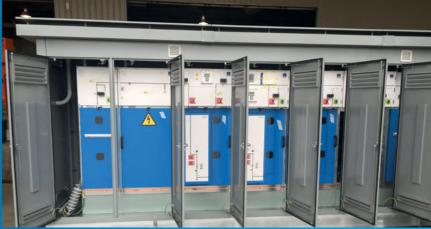
24kV DF2 switchgear in kiosk, with Agile P14D feeder protection relays
